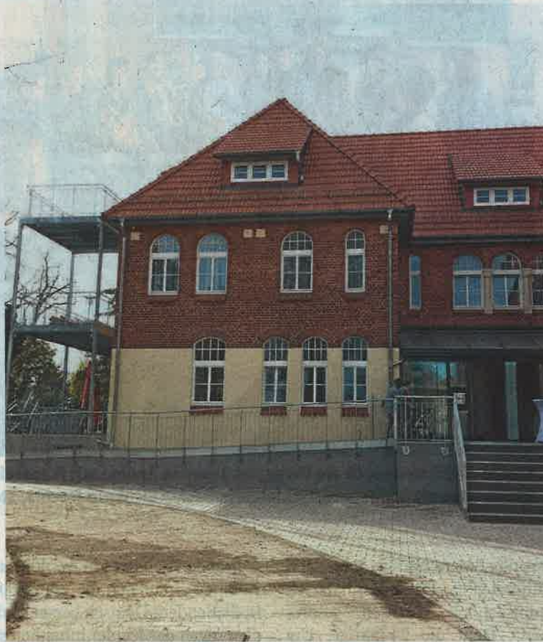
Haus II des Gebäudekomplexes der Stiftung Carolinenheim wurde saniert und bietet nun moderne Bedingungen.
